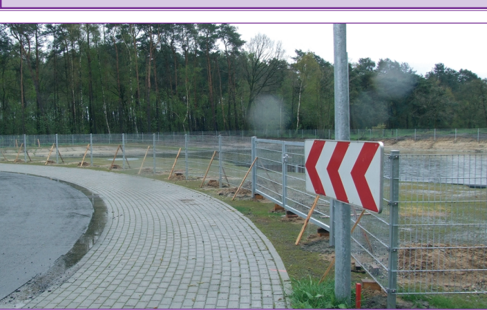
Das Regenrückhaltebecken an der Borggrevestraße
